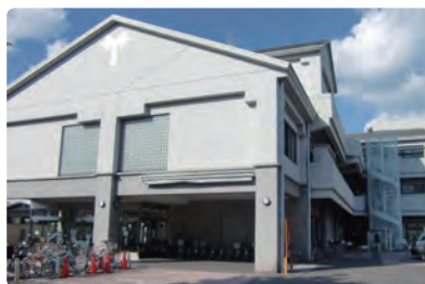
区域の地域福祉活動の拠点 = 写真は、伏見区社協事務局がある伏見社会福祉総合センター (1992 (平成 4) 年開設)。
